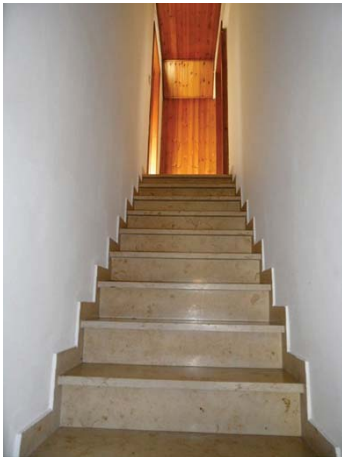
ingesloten trap zonder handgreep
