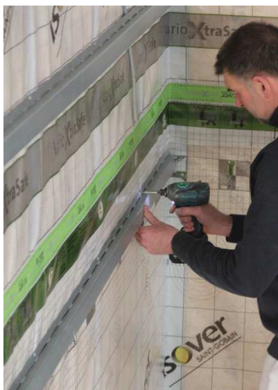
Figuur 58: Bevestiging van (metalen) lattenstructuur
