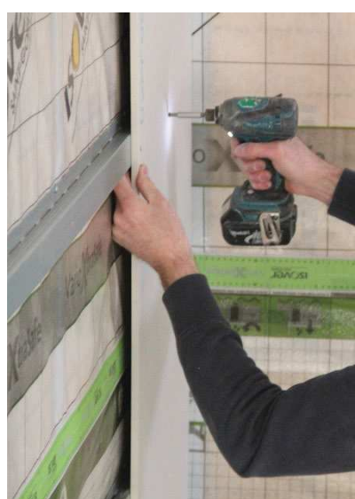
Figuur 60: Afwerkingsplaten op leidingenspouw
