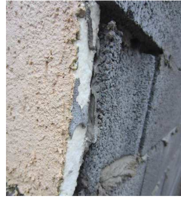
Figuur 63: Pleisterlaag (roze) op EPS (wit)
