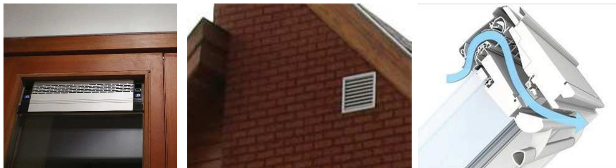
Figuur 224: Roosters op beglazing, in muur, in raamprofiel
