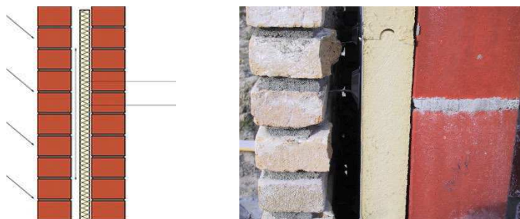
Figuur 66: Spouwmuur gedeeltelijk gevuld met isolatie
