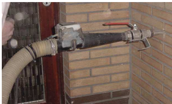
Figuur 100: Plaatsen van na-isolatie
