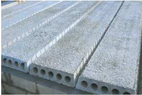
Figuur 77: Holle welfsels
