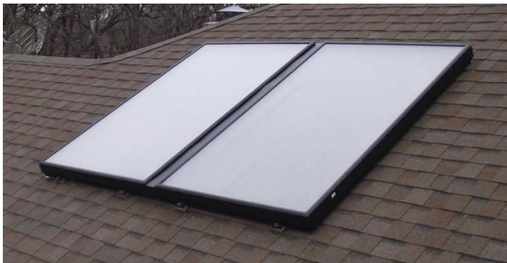
Figuur 34: Vlakke plaatcollectoren
