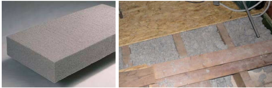
Figuur 113: Cellulose in panelen (links) en in bulk (rechts)
