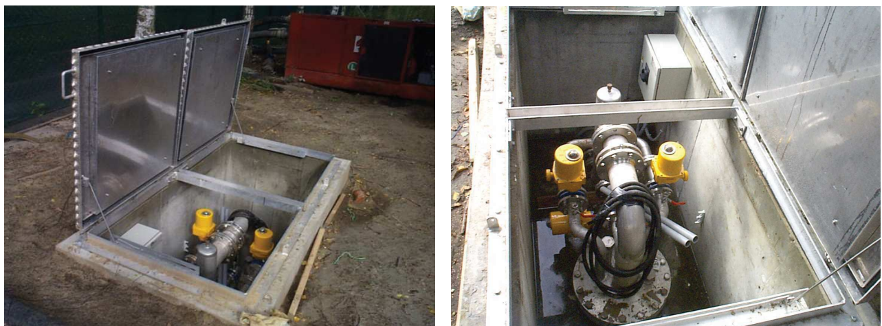
Figuur 44: Collectorput geo-cooling open systeem.
