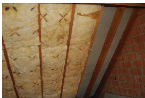
Figuur 82: Isolatie tussen de kepers
