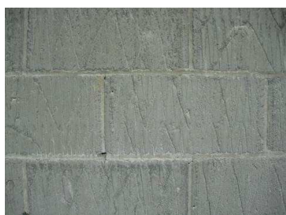
Figuur 70: Cellenbetonblokken van voor de jaren '80
