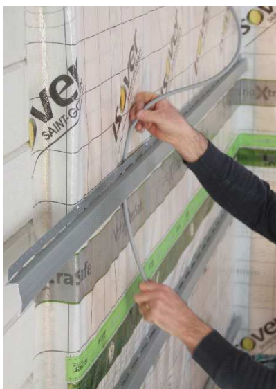
Figuur 59: Doorvoeren van leidingen door leidingenspouw
