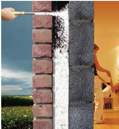
Figuur 68: Na-isoleren van traditionele spouw
