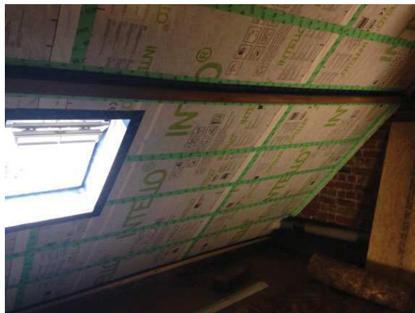
Figuur 74: Dampscherm bij een hellend dak
