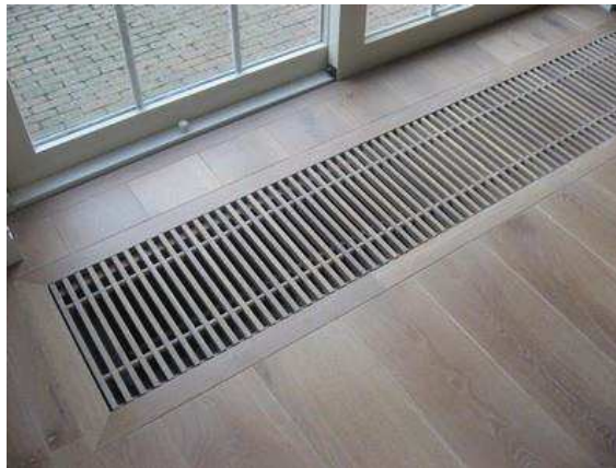
Figuur 56: Voorbeeld van een convector geplaatst in een convectorput
