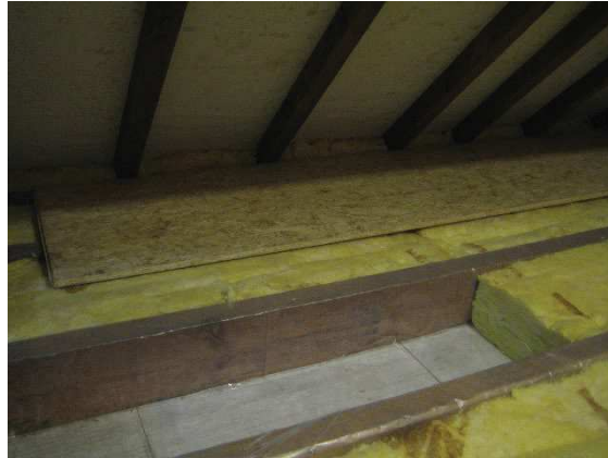
Figuur 88: Zichtbaar gelaten plafondisolatie in houten roostering
