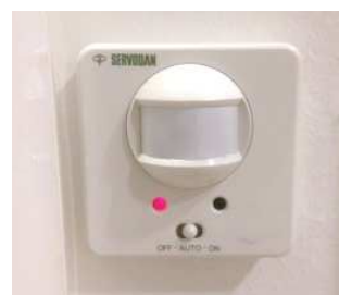
Figuur 88: Inbouwsensor (muur)
