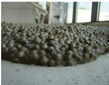
Figuur 75: Isolerende uitvullingslaag met EPS korrels
