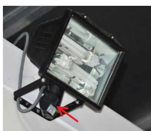
Figuur 86: in het armatuur geïntegreerde sensor
