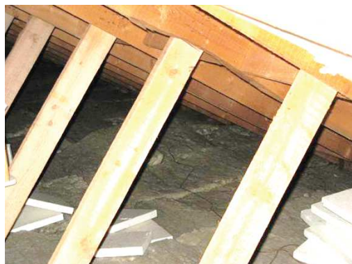
Figuur 104: Voorbeeld van een plafond (zoldervloer) waar de isolatie zichtbaar is vanaf de bovenzijde
