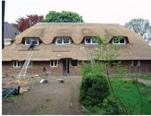
Figuur 84: Hellend dak in riet
