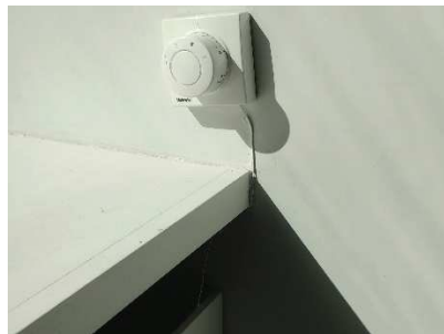
Figuur 60: Voorbeeld van een verplaatste thermostaatkraan
