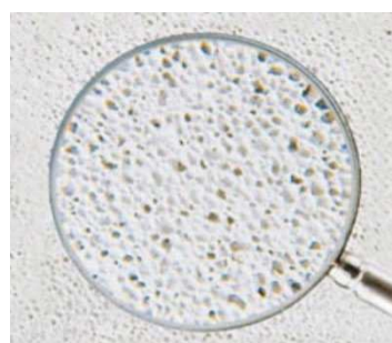
Figuur 72: Poreus oppervlak cellenbeton
