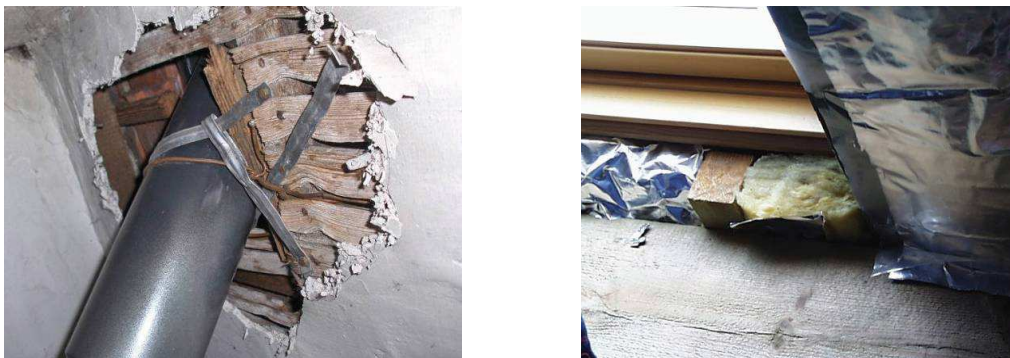
Figuur 103: Visuele inspectie van de mogelijke aanwezigheid van isolatie in hellende daken
