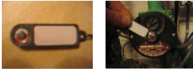
Figuur 166: Magneet om de werking van de circulatiepomp te controleren
