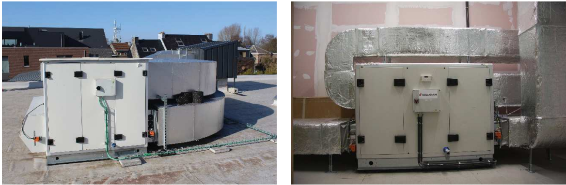
Figuur 45: voorbeelden van mechanische toevoer- en afvoerventilatorgroep
