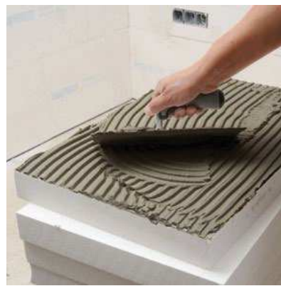
Figuur 57: Lijm op binnenisolatie
