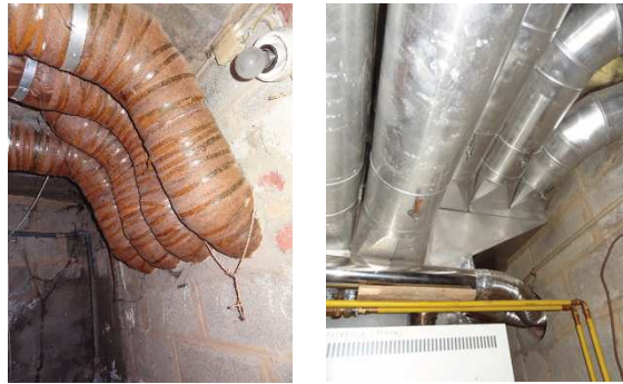
Figuur 57: Voorbeelden van warmtetransport door lucht
