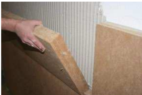
Figuur 56: Lijmen van binnenisolatie
