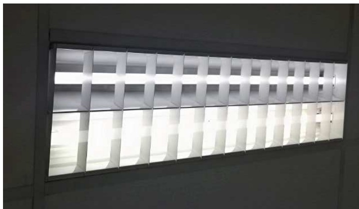
Figuur 253: armatuur met twee verschillende types lampen. De onderste lamp straalt licht in alle richtingen en is dus een TL-lamp. De bovenste lamp straalt licht onder een hoek uit, dit is een LED-lamp
