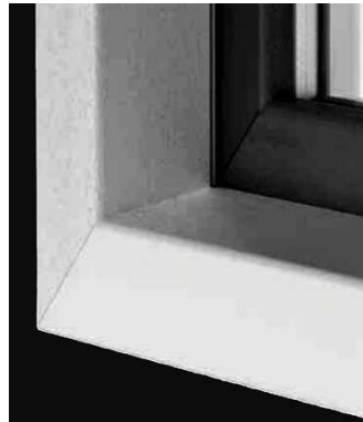
Figuur 127: Montage kunststof kader
