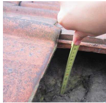
Figuur 81: Isolatie rechtstreeks onder dakpannen
