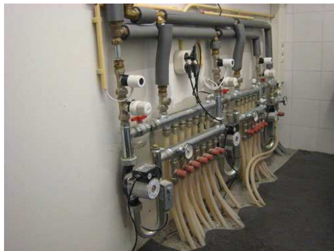
Figuur 202: Collector voor oppervlakteverwarming
