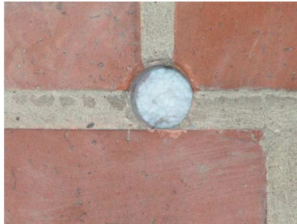
Figuur 67: Inblaasopening bij na-isolatie
