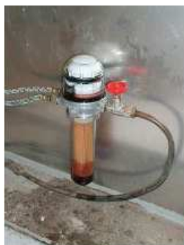
Figuur 126: Stookoliefilter met ontluchtingssysteem
