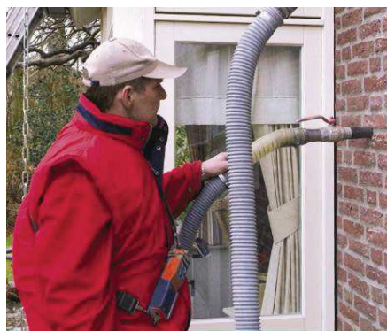
Figuur 73: Plaatsen van na-isolatie
