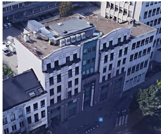
Figuur 14: Technische ruimte op het dak van een appartementsgebouw
