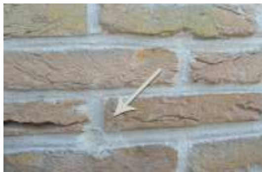
Figuur 101: Zicht op de geboorde gaten in het buitenmetselwerk
