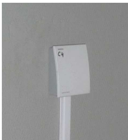
Figuur 62: Voorbeeld van een binnentemperatuursensor
