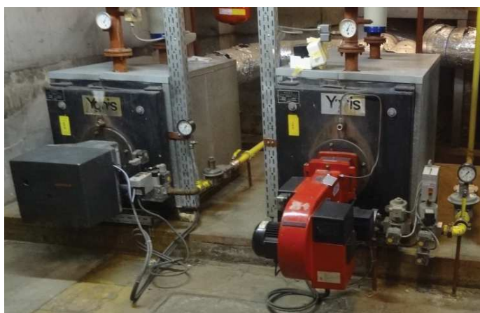
Figuur 31: Voorbeelden van ketels uitgerust met opbouwbranders
