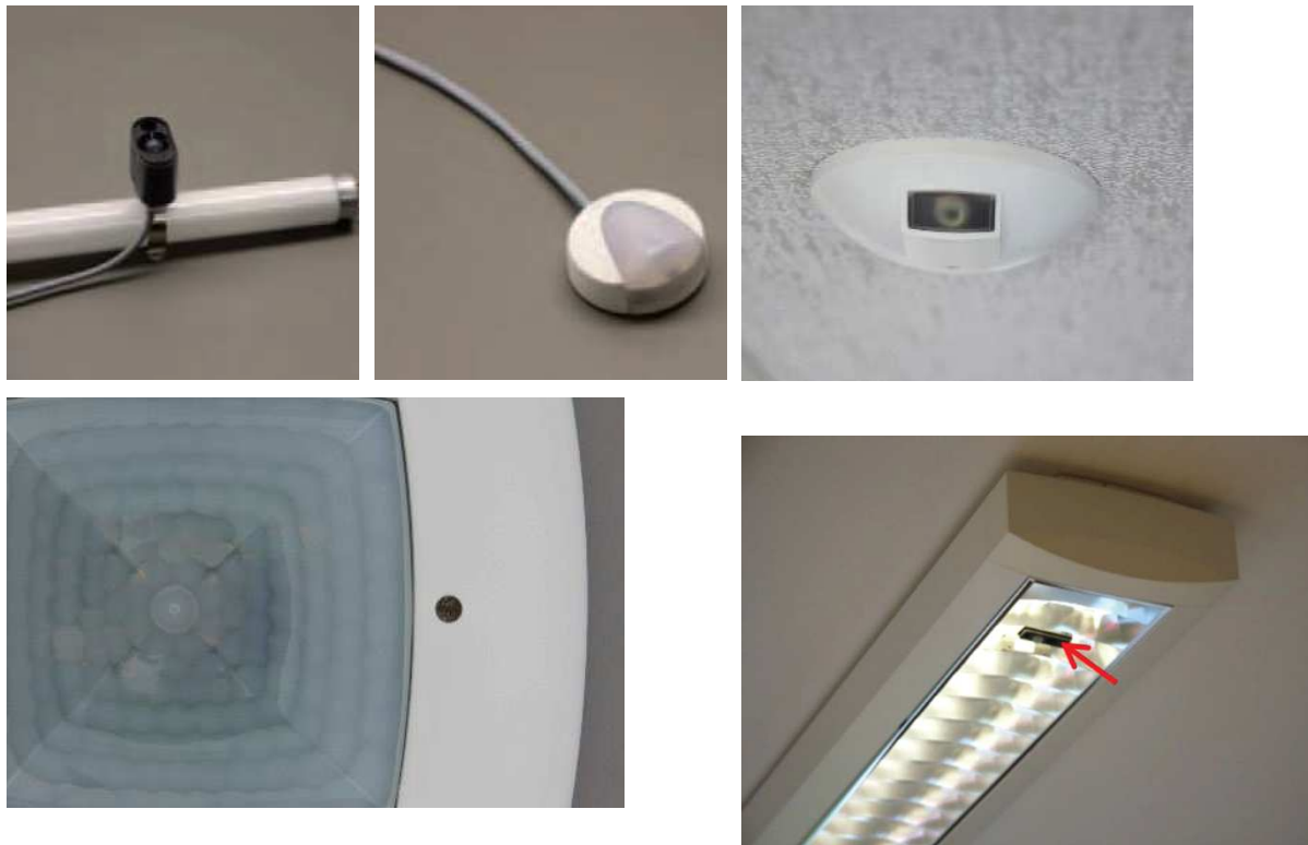
Figuur 260: Sensor voor verlichtingssterkte/daglichtsensoren: rechtstreeks op de lichtbron (boven links), voor opstelling aan het plafond in de ruimte (boven midden en rechts) en daglichtsensor geïntegreerd in sensor voor aanwezigheidsdetectie (onder links)
