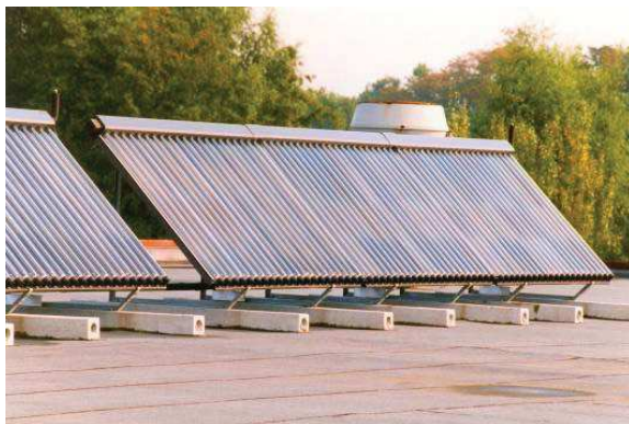
Figuur 238: Buiscollectoren (links) en vlakke plaatcollectoren (rechts)
