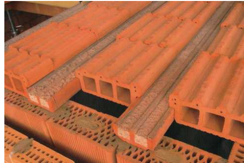
Figuur 78: Potten en balken
