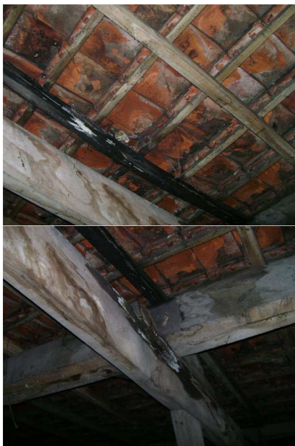
ernstige aantasting houten keper en spant
