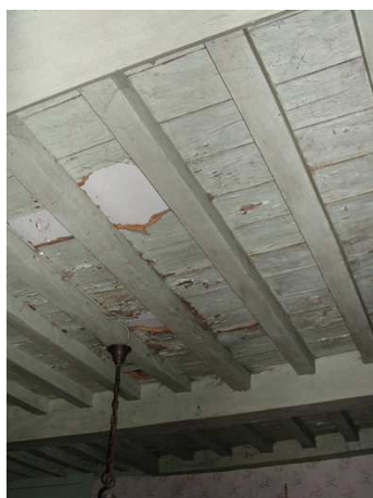
gat in verdiepingsvloer voorlopig gedicht
