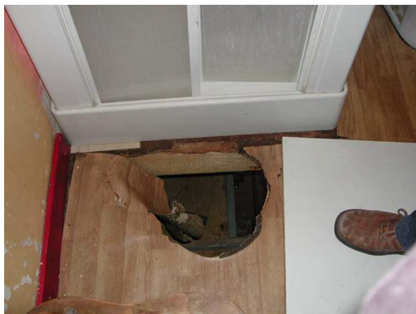
gat in de verdiepingsvloer
