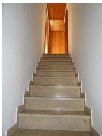
ingesloten trap zonder handgreep
