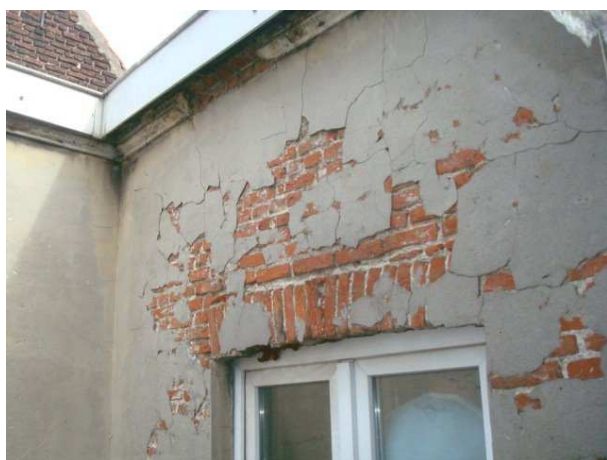
loskomende cementering op deel achtergevel
