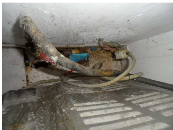
elastomeren slang voor fornuis
