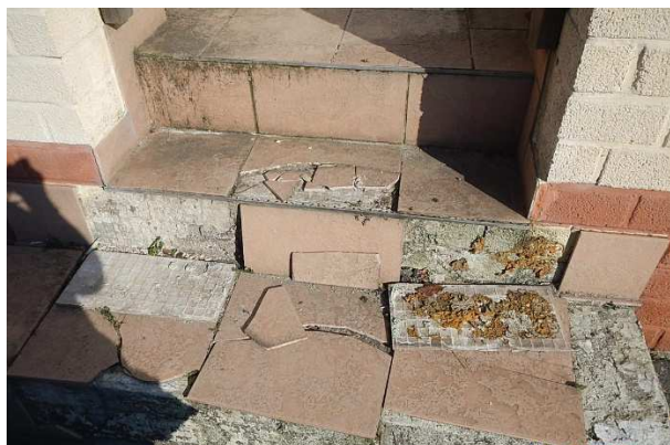
Loskomende en beschadigde tegels bij inkom
