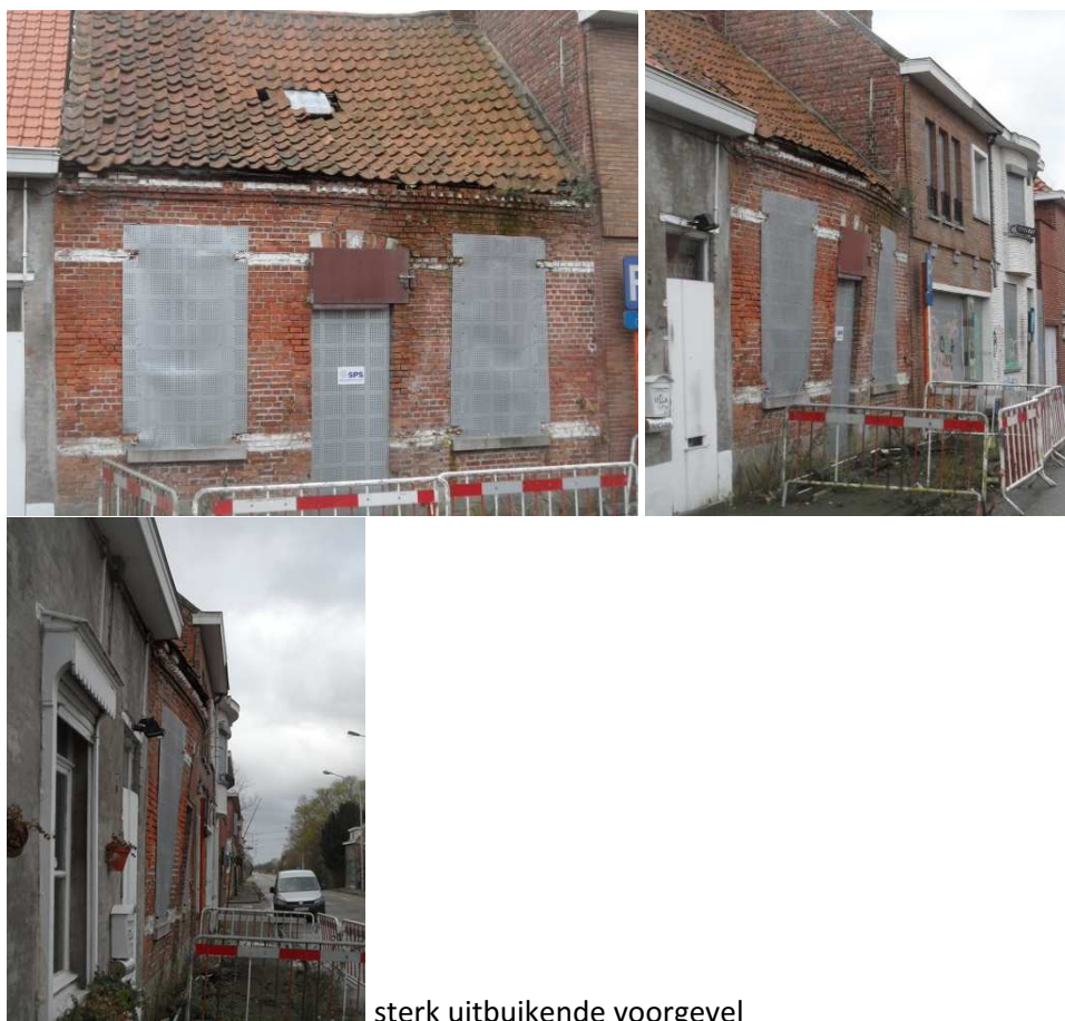
sterk uitbuikende voorgevel
