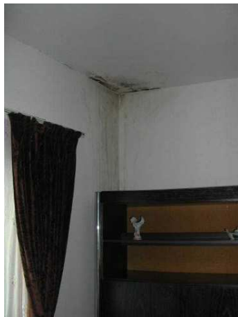
insijpelend vocht met beperkte schimmelvorming
