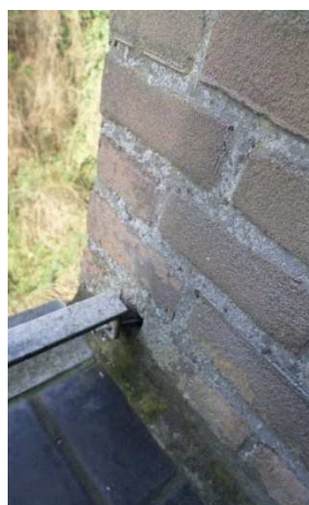
Borstwering los, bevestiging te licht.
