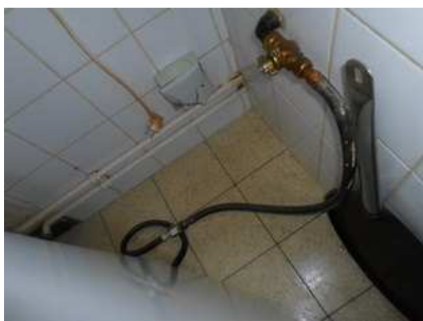
elastomeren slangen (gekoppeld) voor fornuis
