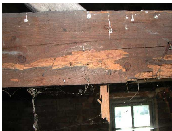
aantasting houten dakspant door insecten
