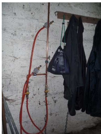
te lange verbinding met gasslangen
