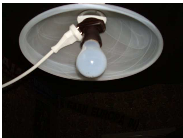
stopcontact in de leefkamer ontbreekt
