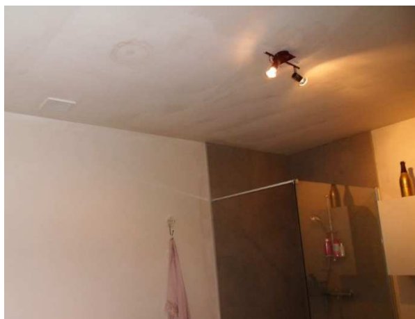
opdrogende pleister bij nieuwbouw
