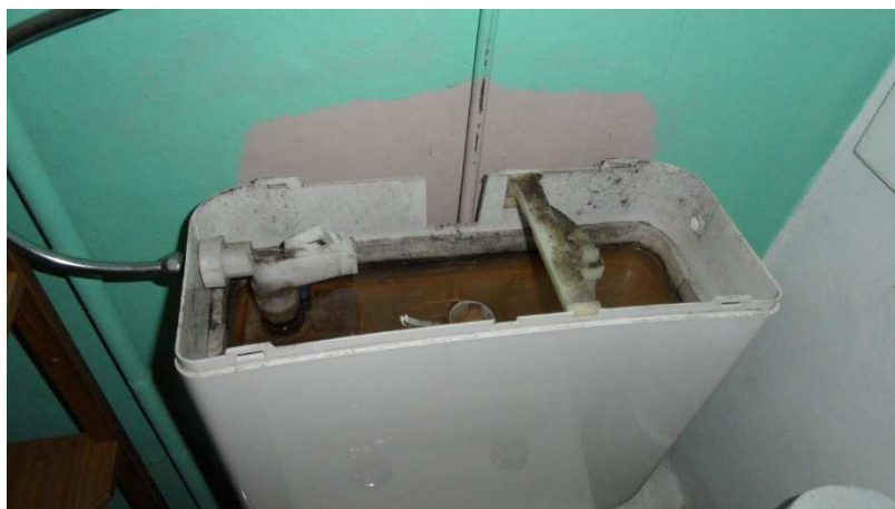
Spoelmechanisme beschadigd
