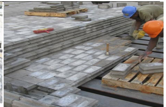
Photo 2 : pose des blocs sur les poutrelles
