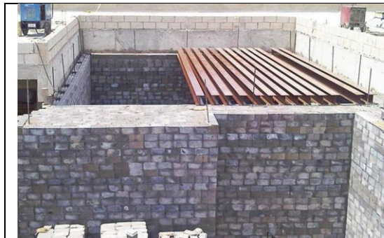
Photo 1 : poutrelles pour supporter le plafond
