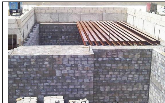
Photo 1 : poutrelles pour supporter le plafond
