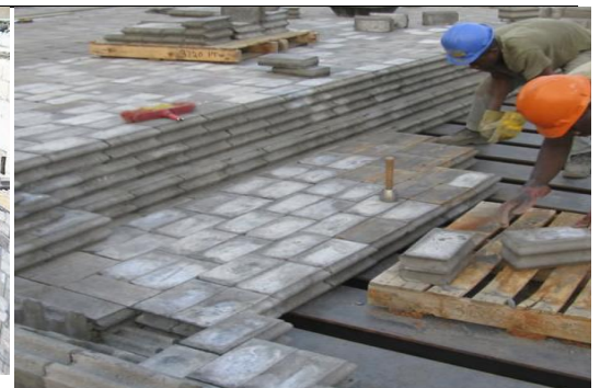
Photo 2 : pose des blocs sur les poutrelles
