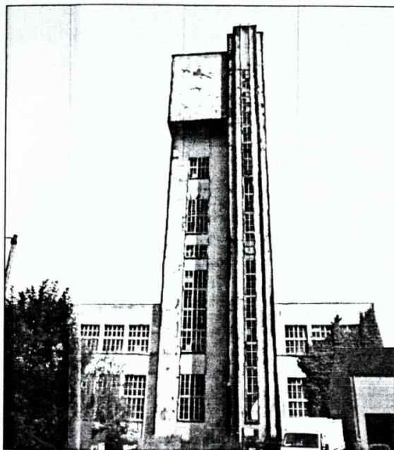
Façade Sud - Situation existante
